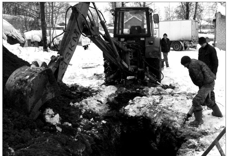
Именно перед ним, на стыке асбестоцементной и металлической труб, образовался нынешний прорыв. Земля в этом месте сильно промерзла, и, чтобы добраться до трубы, слесари сначала отбойными молотками снимали мерзлый слой, а потом вступал в работу экскаватор.
