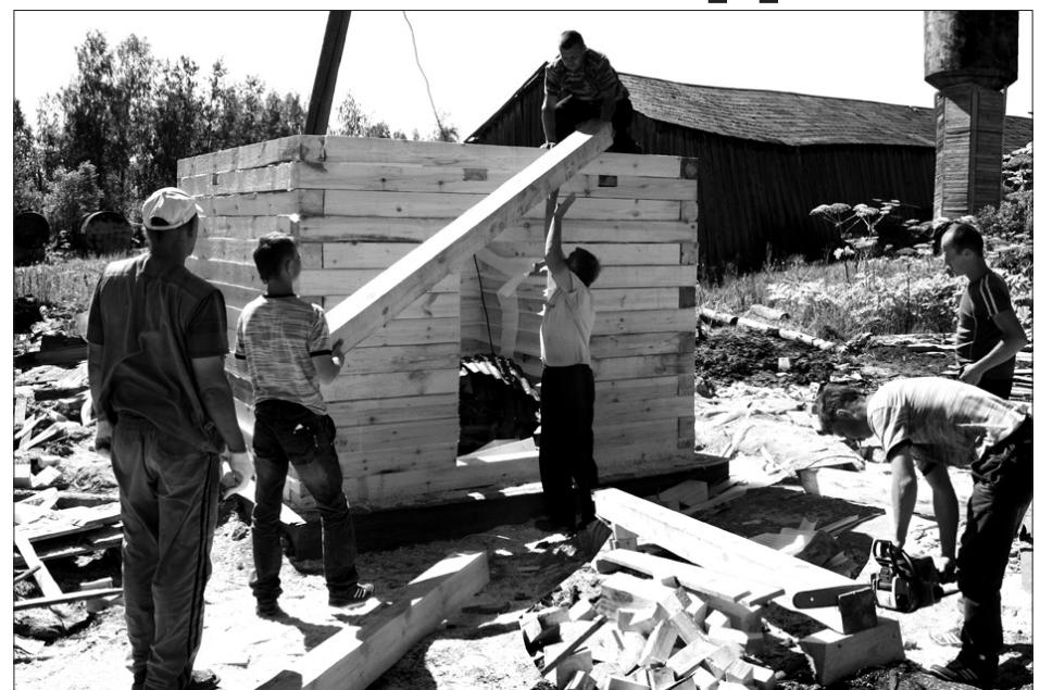
на следующий день старую постройку снесли и залили новый фундамент, позже – возвели стены и кровлю, смонтировали электрооборудование.
